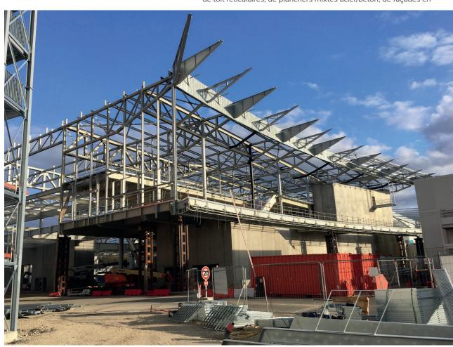
porte-à-faux et de passerelles techniques suspendues au toit. Cette structure supporte les charges de la sousstructure du revêtement de façade en tôle perforée constitué de grilles spatiales.
